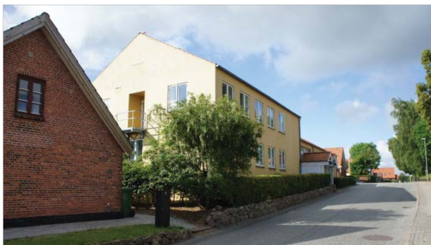
Efterskolens overnatningsfaciliteter på sydøstsiden af Havnevej - fotovinkel F
