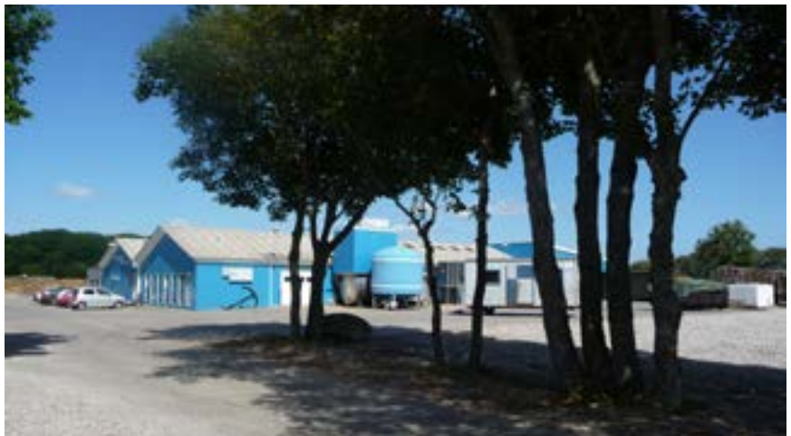
Fig. 3. Eksisterende erhvervsbebyggelse i den centrale del af lokalplanområdet.
