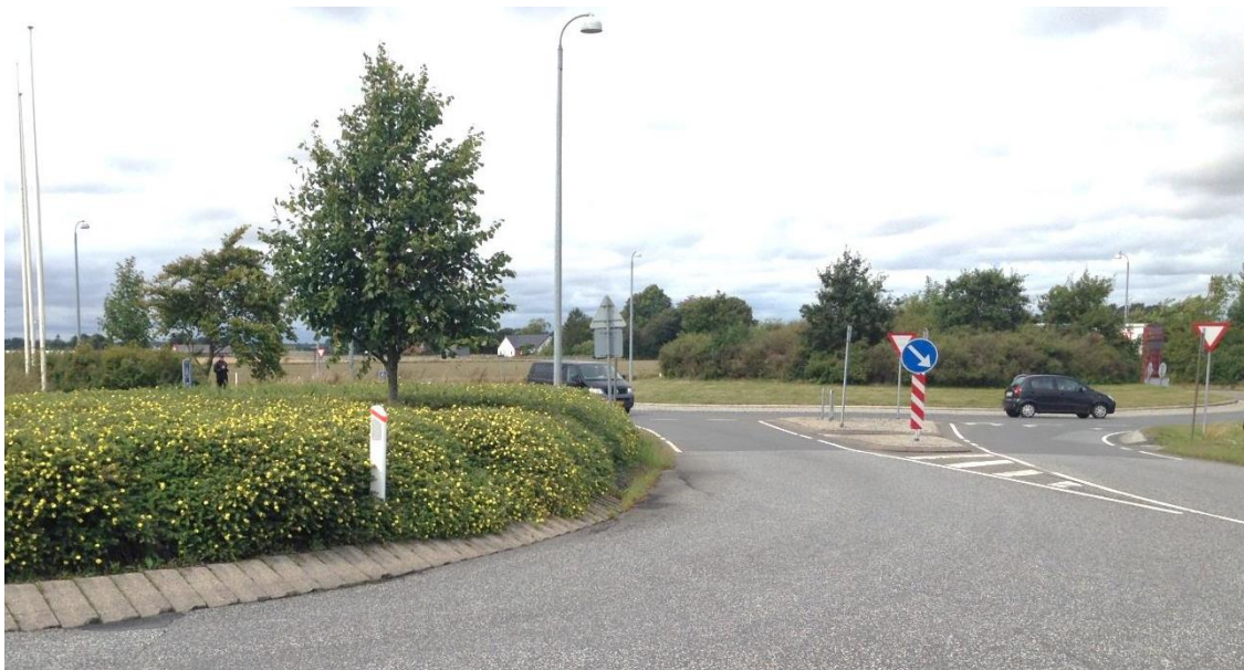
Figur 3 Oversigt fra Overholmvej mod rundkørslen (rute 170). Bemærk at beplantning delvist skjuler blinklys på den høje varevogn.
