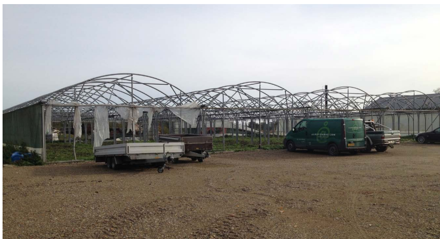
Billede 2: Eksisterende væksthuse. I forgrunden ses parkering P2.
