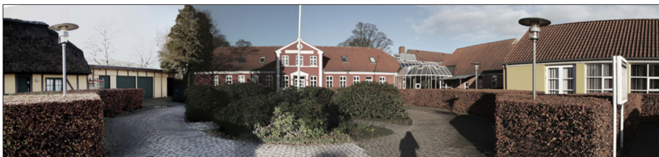
Foto viser de eksisterende historiske bygninger - præsteboligen i midten og driftbygningen til venstre.
