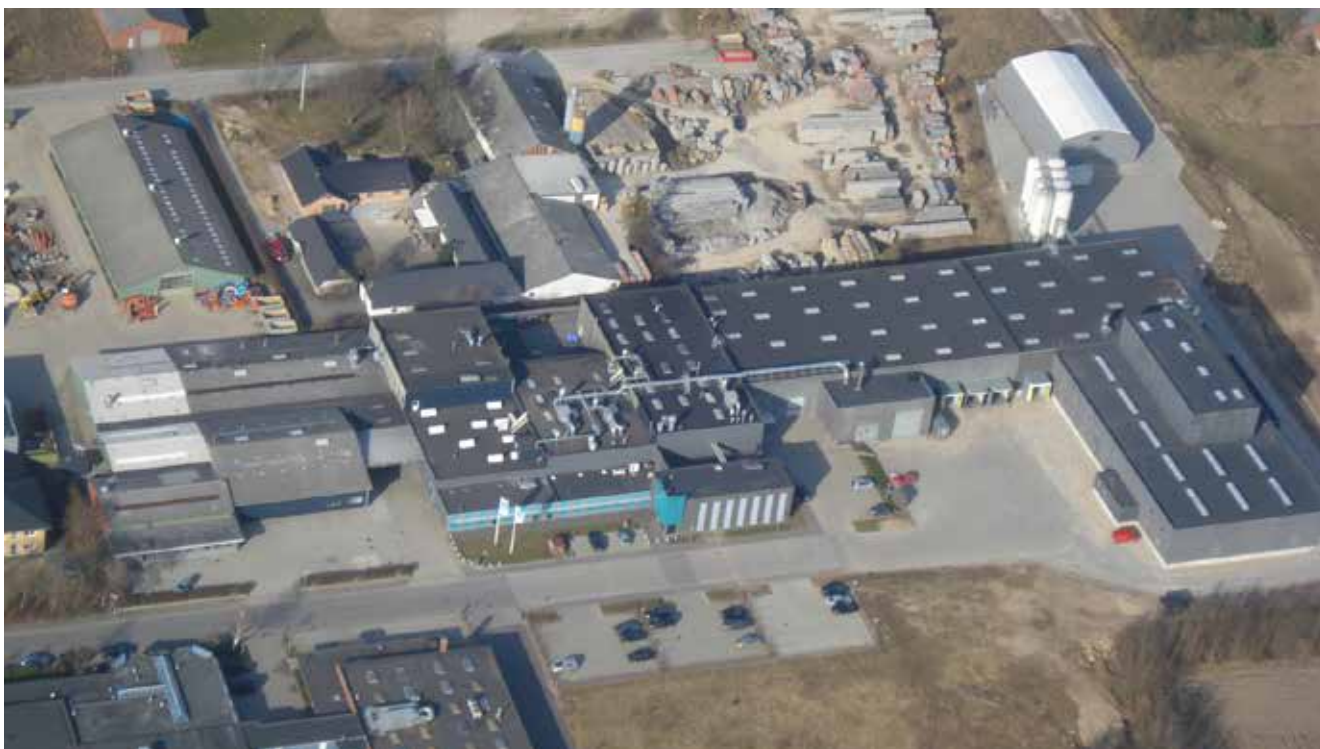
Luftfoto, som viser den eksisterende virksomhedes bebyggelse og anlæg i 2014
