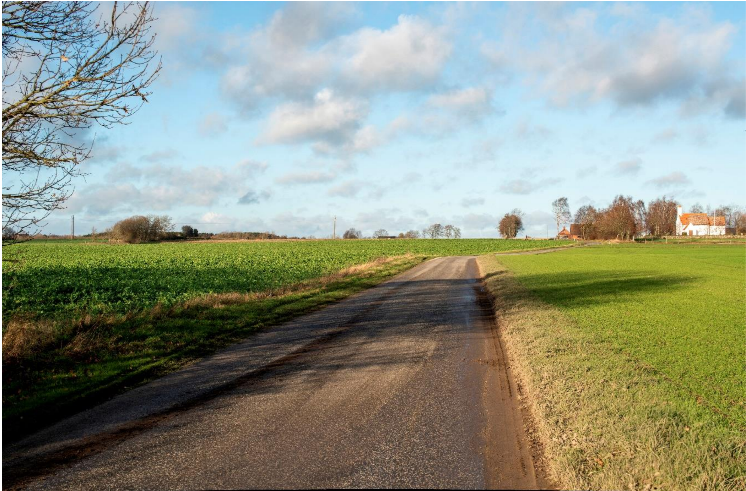
Fig. 7a Standpunkt nr. 6 eksisterende forhold
