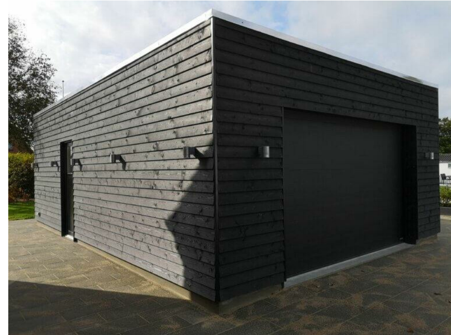
Zink inddækning af murkrone som vist på billedet
