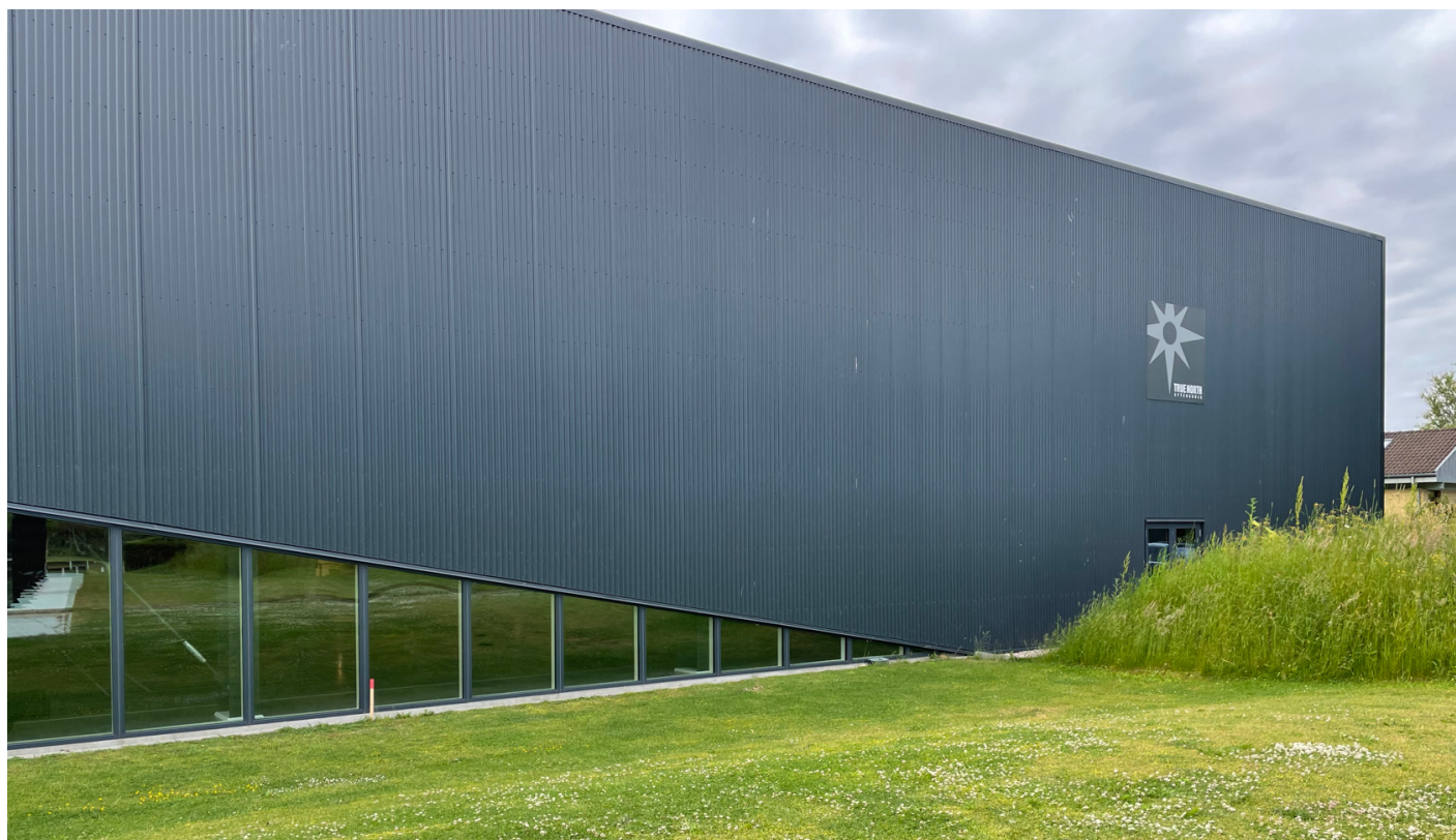
Sinus plader og murkrone inddækning som på eksis. hal.
