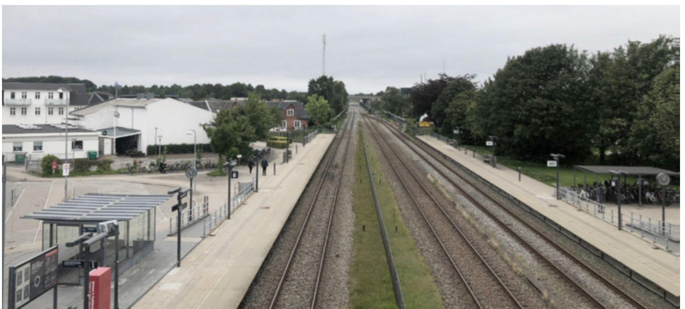
Jernbanen set fra eksisterende gangbro mod nord.
