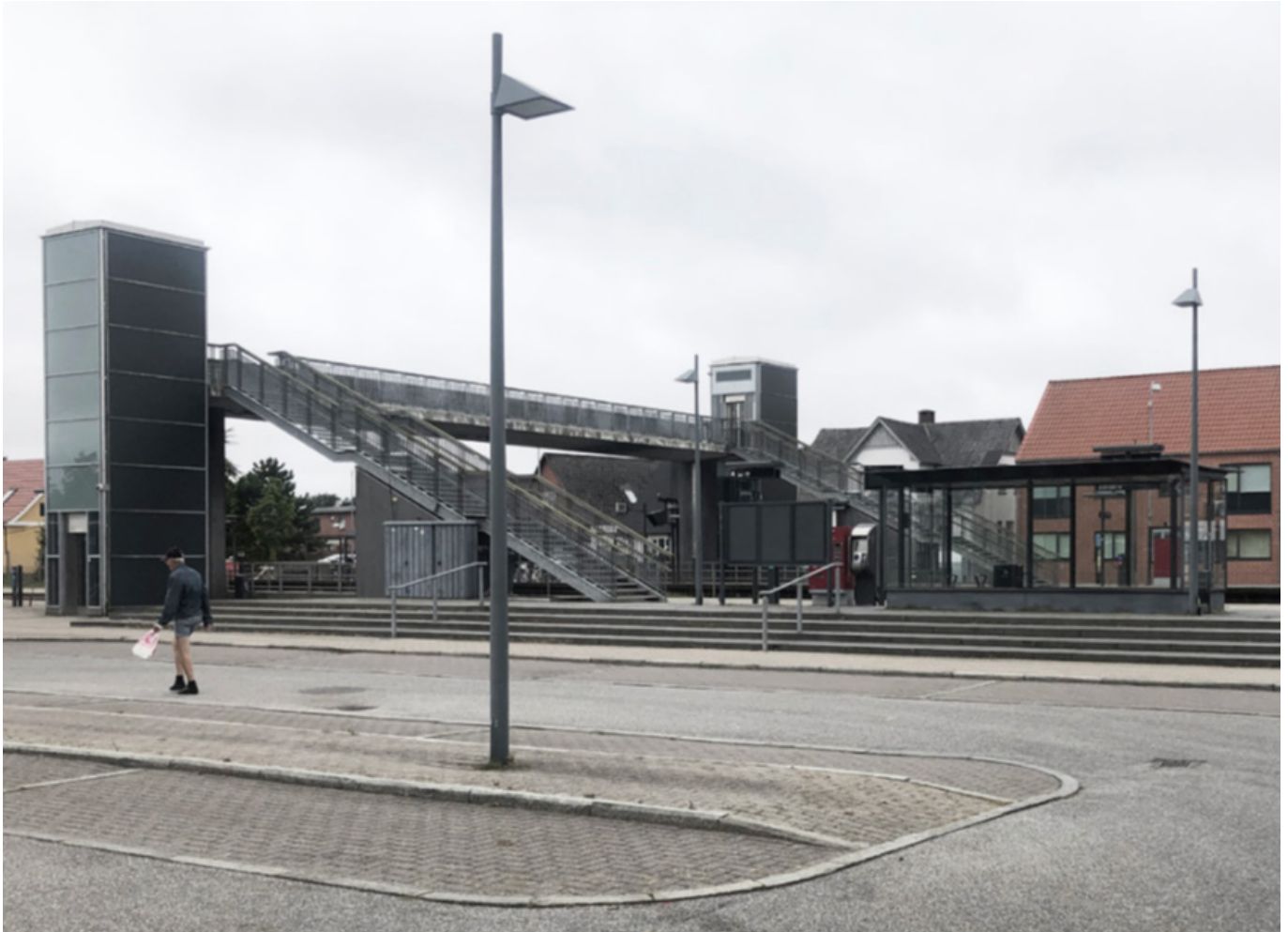
Eksisterende broforbindelse med elevatortårne ved perronen.
