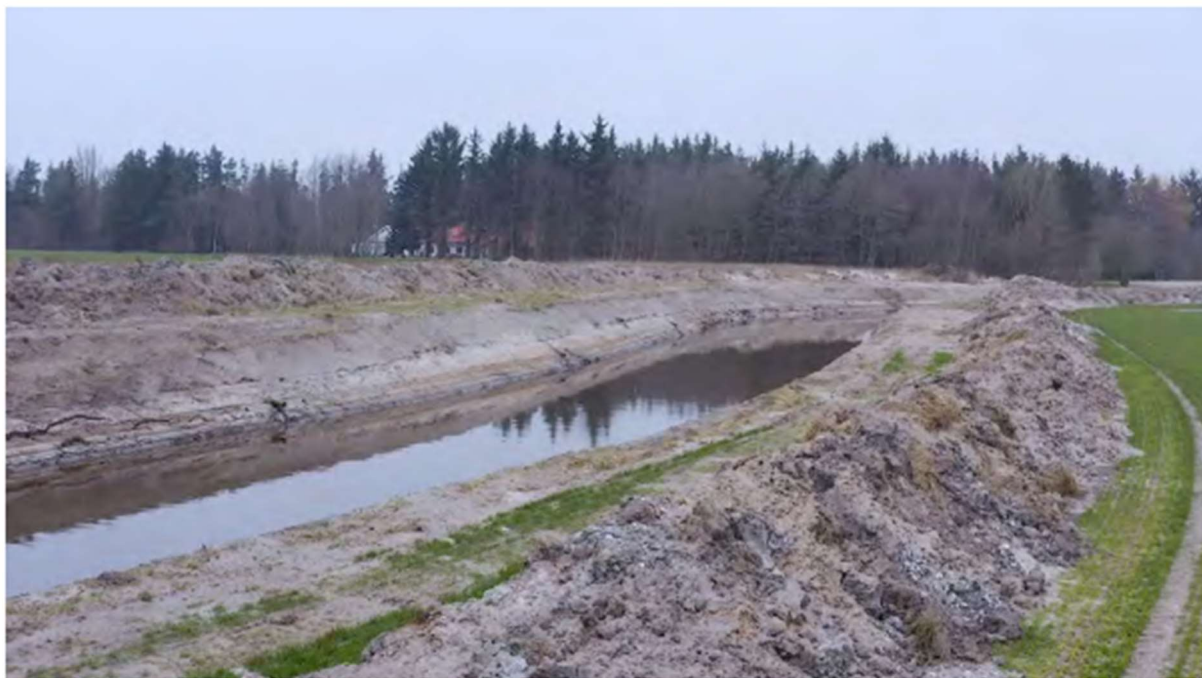
Figur 3. Eksempel på uddybning af et stort vandløb.
