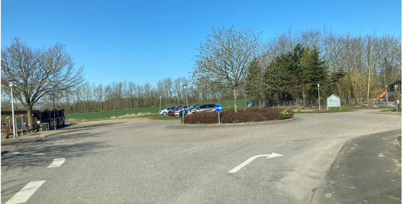
Figur 7 Tydelig anvisning af kørselsretning i rundkørslen ved skolen og børnehaven med en pilmarkering på kørebanen og påbudstavler for retning i midterøen. Selve rundkørslen er udformet i belægningssten.
