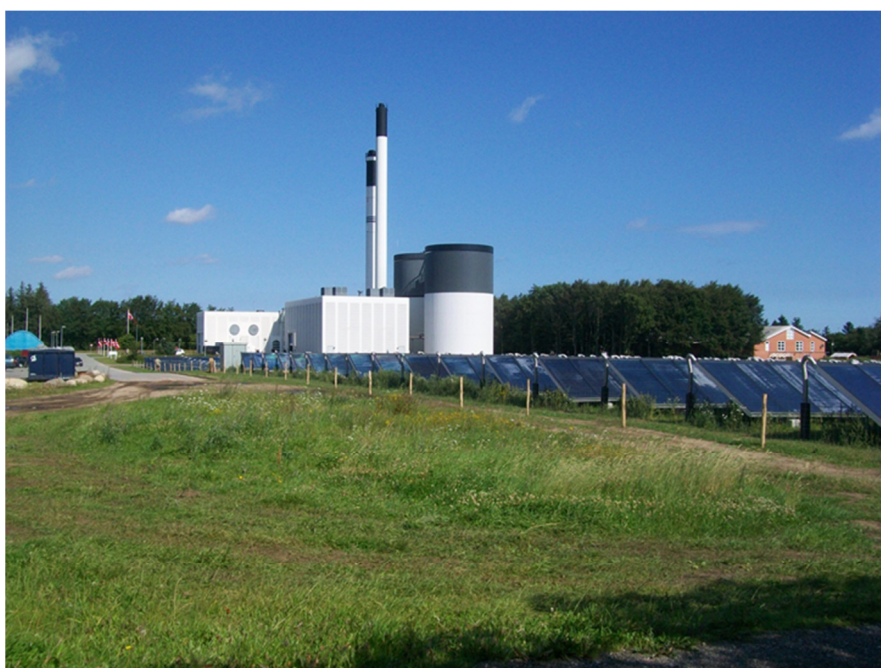
Billede fra idriftsat anlæg med akkumuleringstank
