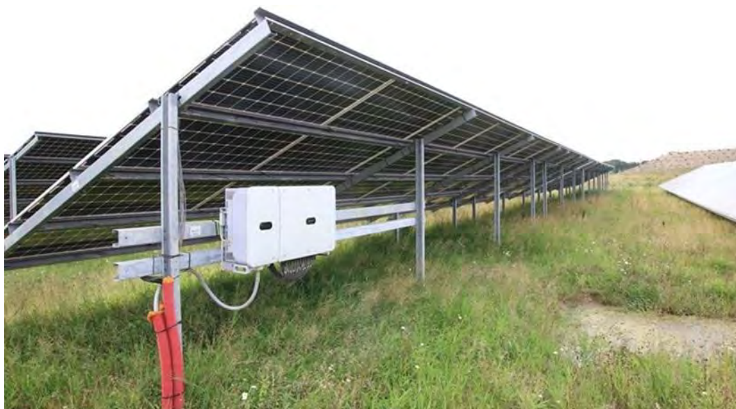
Figur 3-4 Eksempel på inverter, som placeres under solcellerne. Inverterne omdanner jævnstrømmen til vekselstrøm.
