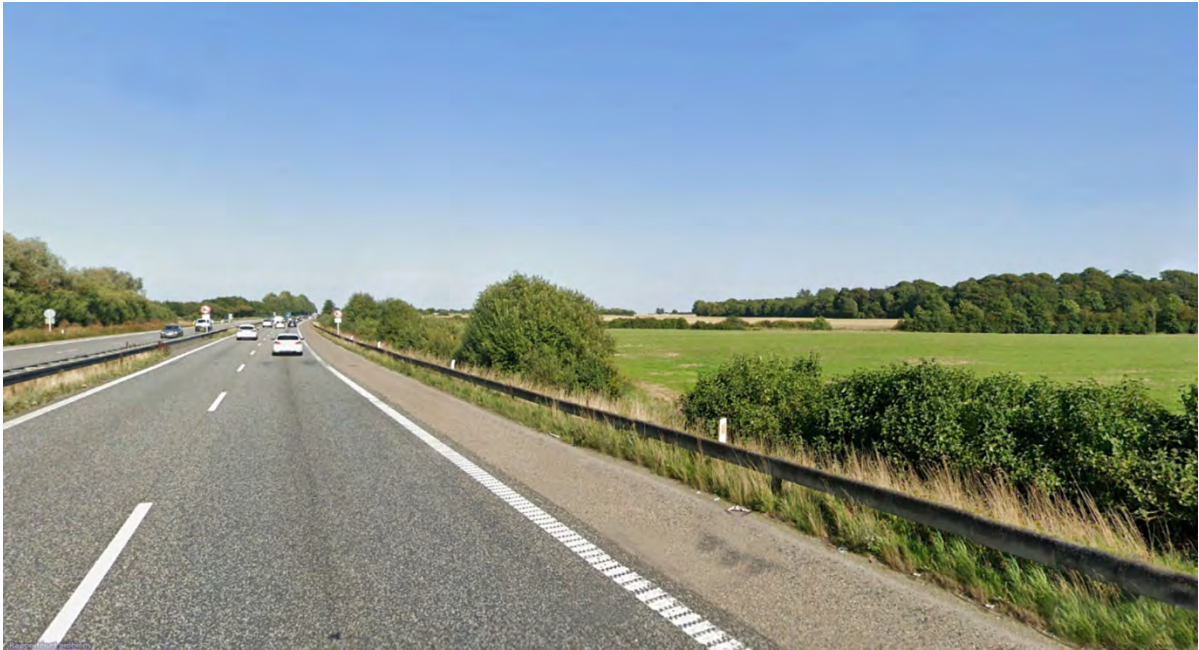
Fra motorvejen er der indkig til projektområdet, navnlig i den sydlige del, hvor vejen ligger i påfyldning og hvor randbeplantningen ikke er sammenhængende.
