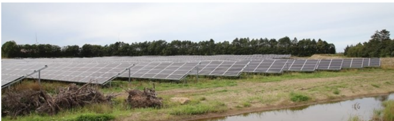
Foto af solcellepaneler på faste stativer.
