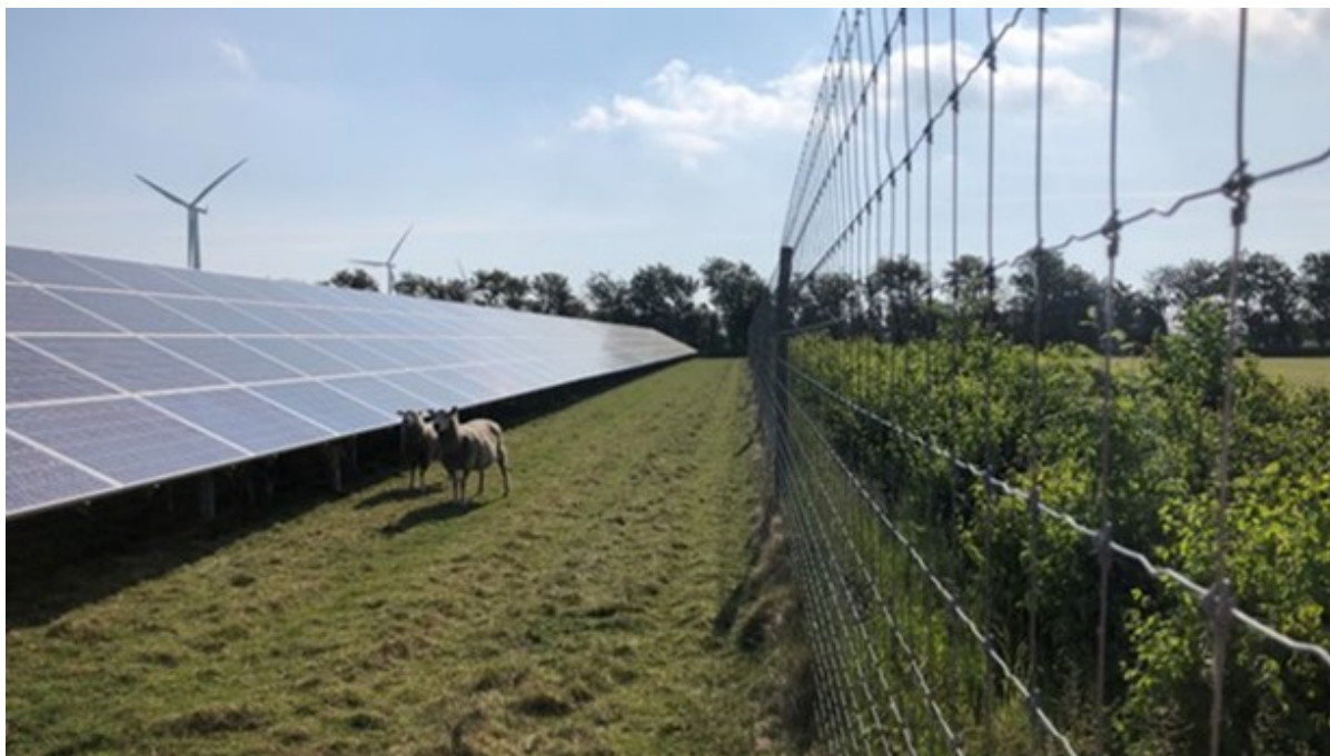
Foto - Eksempel på etablering af paneler på faste stativer, trådhegn og beplantningsbælter.
