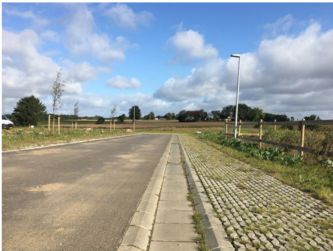
Billede af en færdig boligvej i etape 2. Kørebane i asfalt, vandrende, græsarmering i begge sider samt brede rabatter med vandtrug.
