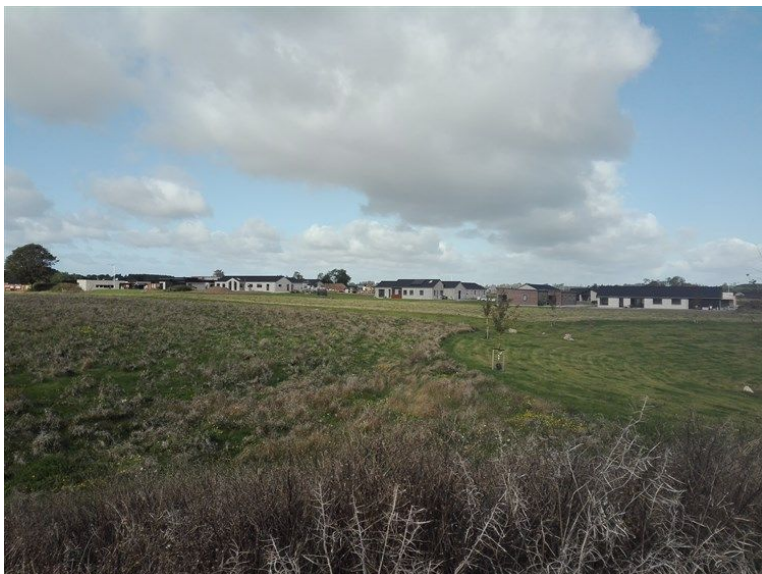
Lokalplanområdet grænser op til etape 1 og 2. På billedet ses etape 1 samt en del af det regnvandsbassin, der er etableret i den grønne kile mellem etape 1 og 3.
