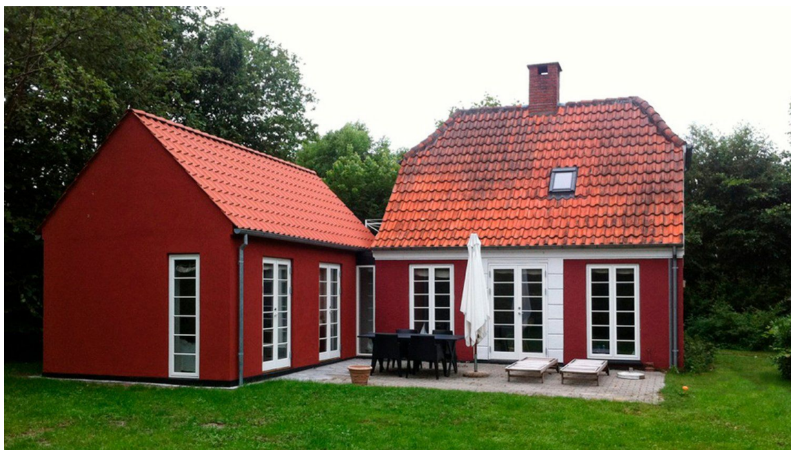
Eksempel på tilpasset tilbygning, hvor tilbygningen er udført i henholdsvis tilpasset formsprog, materialevalg og udtryk (Foto: Bolius.dk)
