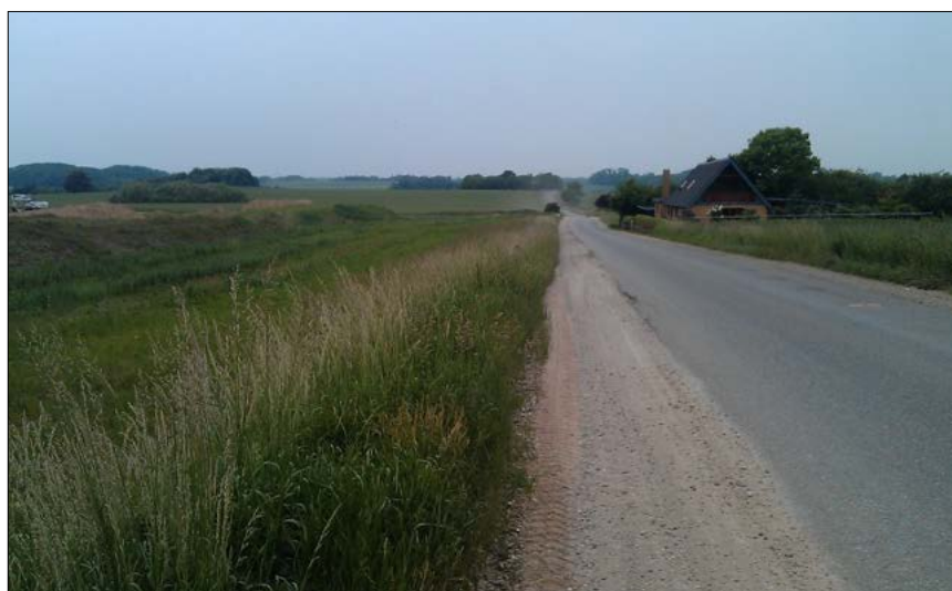
Højkildevej nord for Ørum, hvor omfartsvejen tilsluttes, set mod nord
