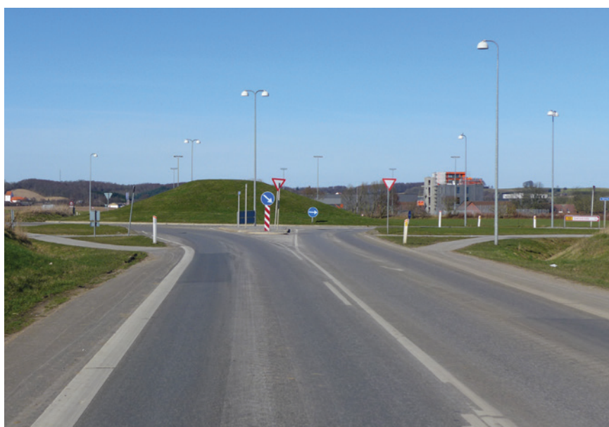
Eksisterende bebyggelser og anlæg set mod vest fra Gramvej
