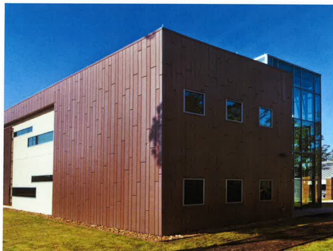
facade med brune zinkkassetter
