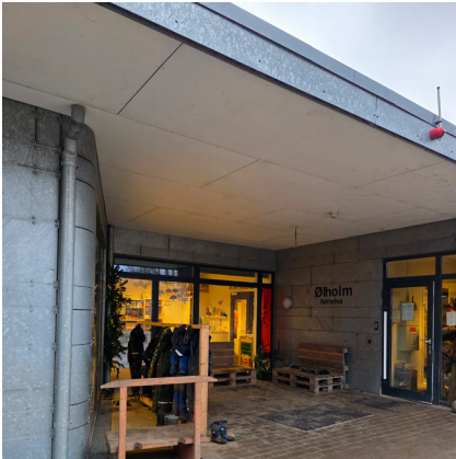
Hvid pladebeklædning under udhæng, som eksis. tilbygning.
