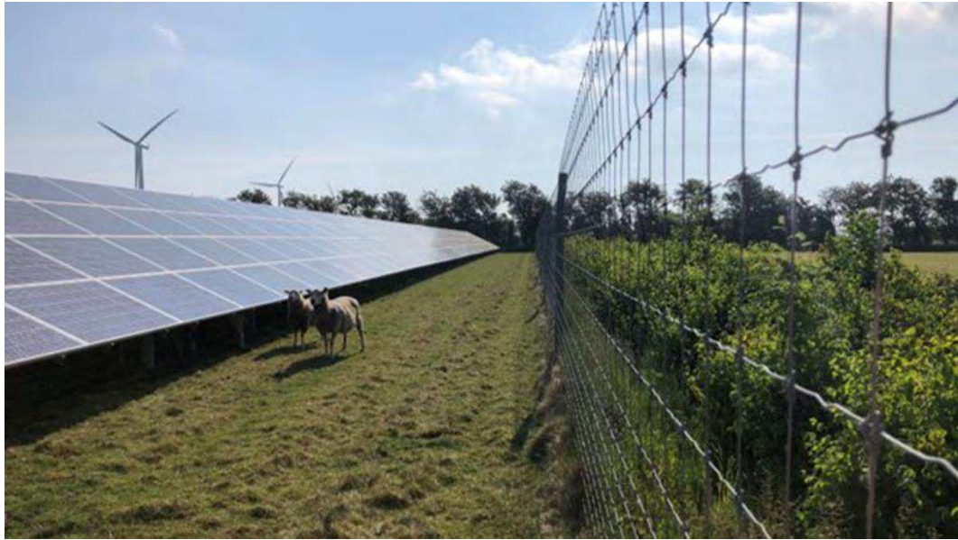
Figur 3-3. Eksempel på etablering af paneler på faste stativer, trådhegn og beplantningsbælter.
